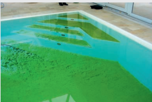
Schwimmbad mit starkem Algenbefall
